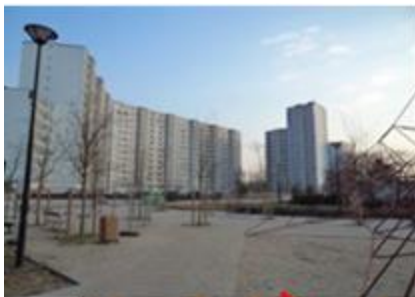
Cité des Franc-Moisins à Saint-Denis
